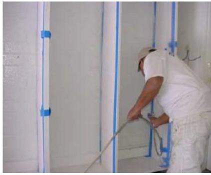
Aplicación del TEMP-COAT 101 en las paredes sin aislamiento.
