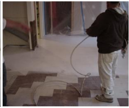
Aplicación del TEMP-COAT 101 en el suelo de baldosas.
